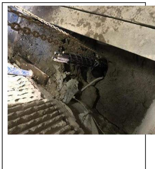
CONSTRUCCIÓN DE PILOTES
