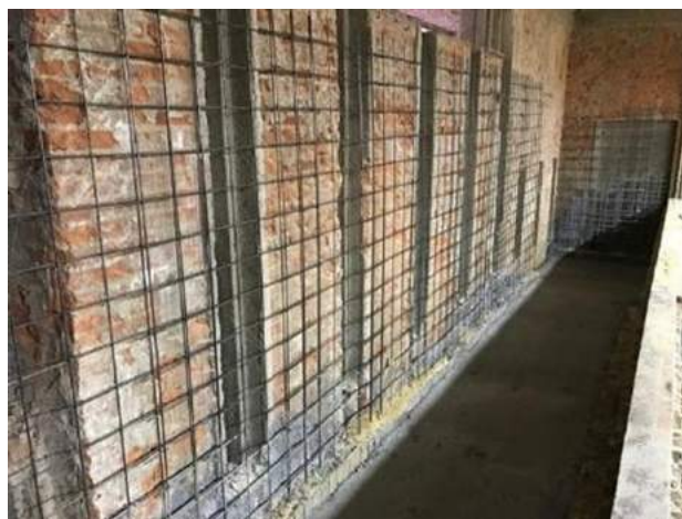
Construcción De Arranques De Pantallas Adosadas
